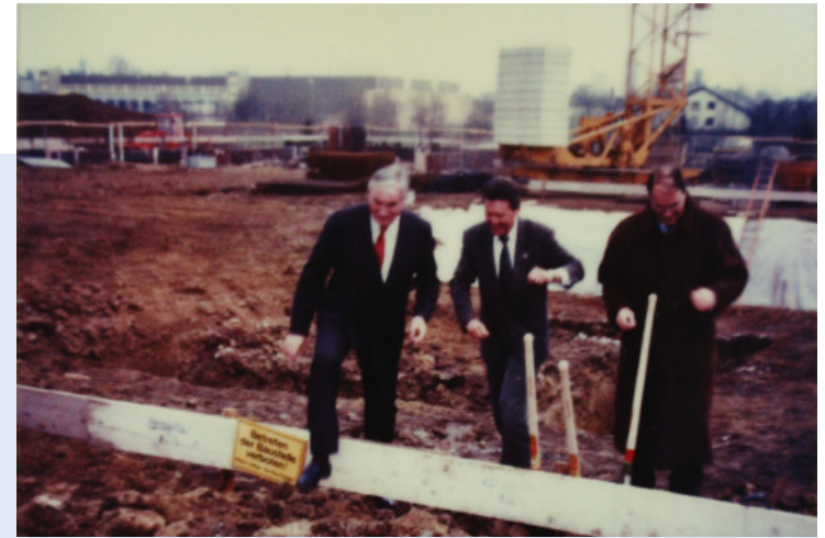
Spatenstich Werkstätte Hausen 1979
